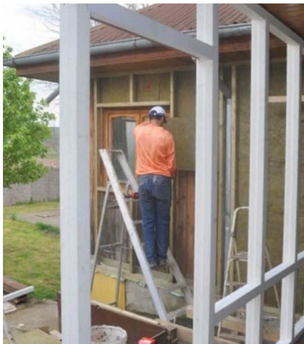
De nieuwe pui levert een fraai doorkijkje...
