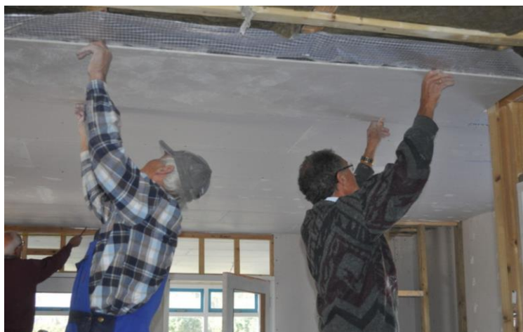
Ochtendgymnastiek: het plaatsen van de plafondplaten...
