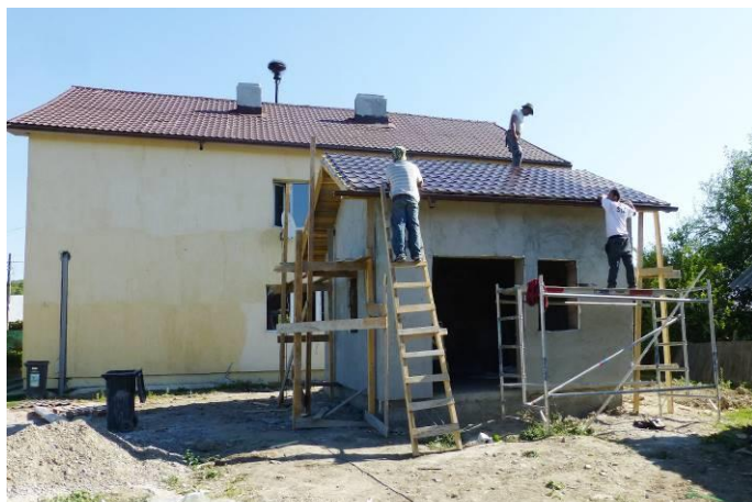
Het ketelhuis in aanbouw...
