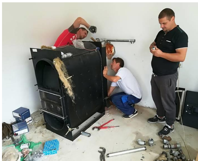
Plaatsing van de houtgestookte ketel...
