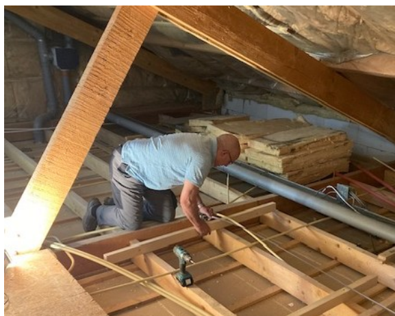
De balkenconstructie voor de 'extra' vloer...
