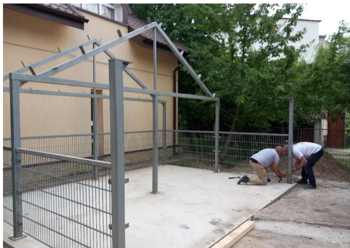
Het stellen van de staalconstructie...
