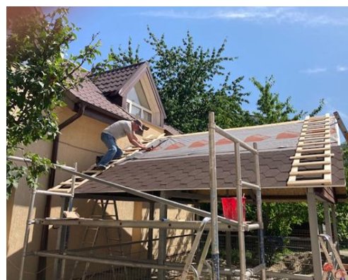
De ontmoetingsruimte in aanbouw...
