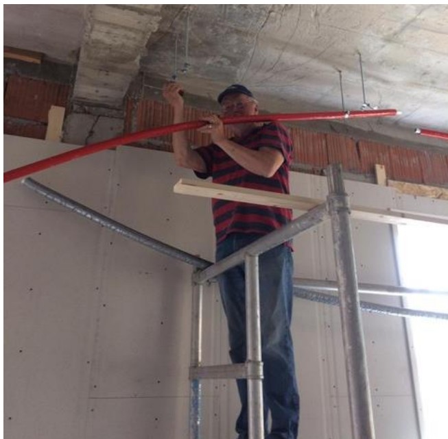
Ophangen van de verwarmingsbuizen...
