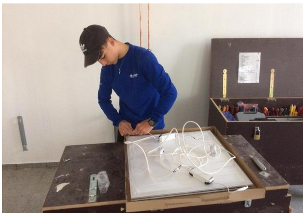
Montage van de LED-verlichting...
