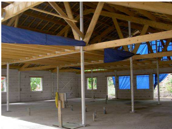
Het dak is dicht...
