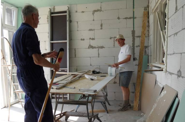
In de warmte, werken aan de wanden...
