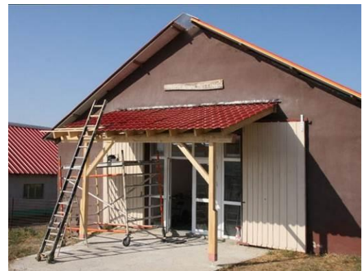
Het gebouw (bijna) gereed...
