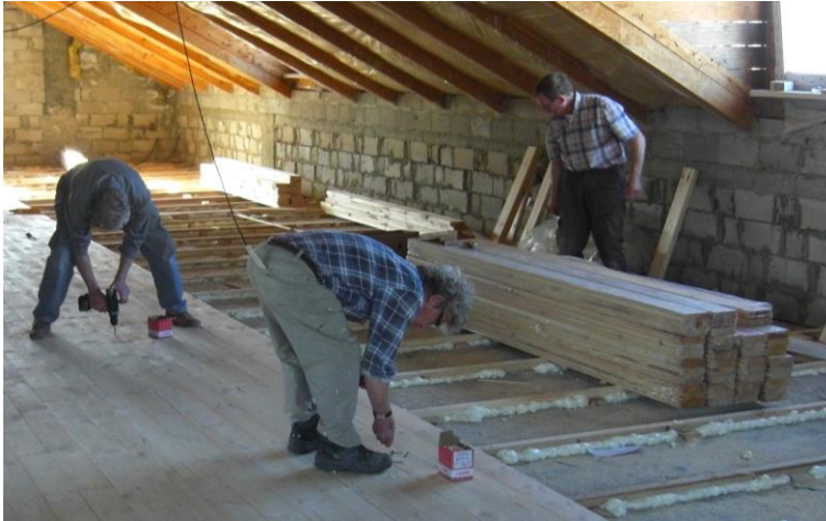
Het leveren van een degelijk stuk werk...
