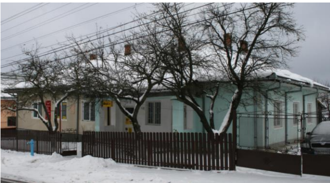
Het te renoveren gebouw...
